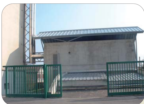
Accès au silo de la chaufferie bois de Tullins (38)
