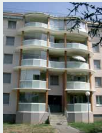
En cours de travaux
