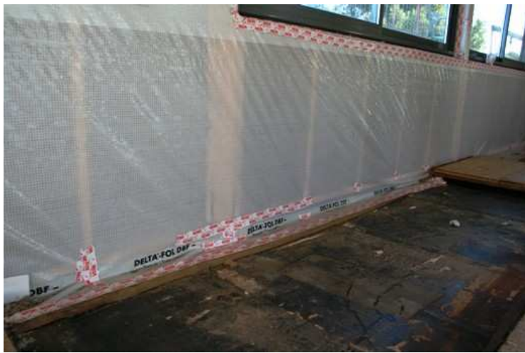
Vue générale de l'absence de contre lattage du freine vapeur collé et agrafé sur l'ossature structurelle.
