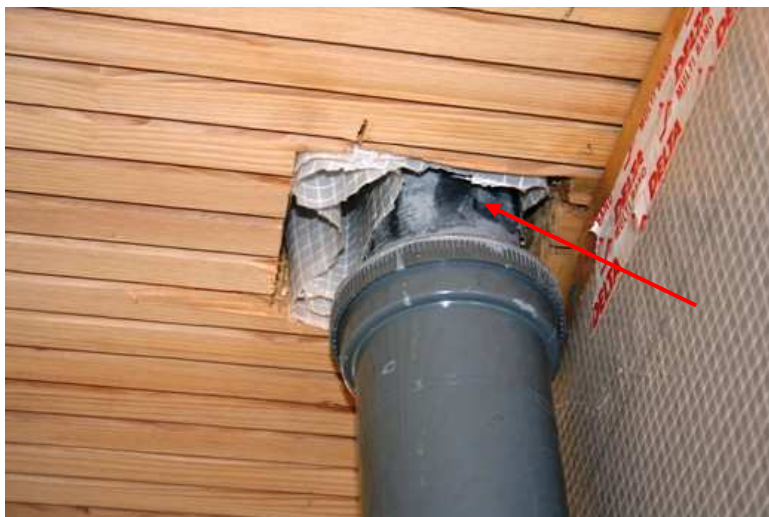
Infiltrations d'air au niveau de la descente EP et au niveau de la trappe d'occultation provisoire du skydome.
