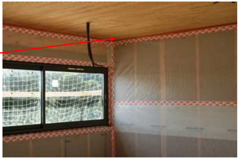
Vue des infiltrations d'air en bordure de Lignotrend dans angle Sud Ouest.
