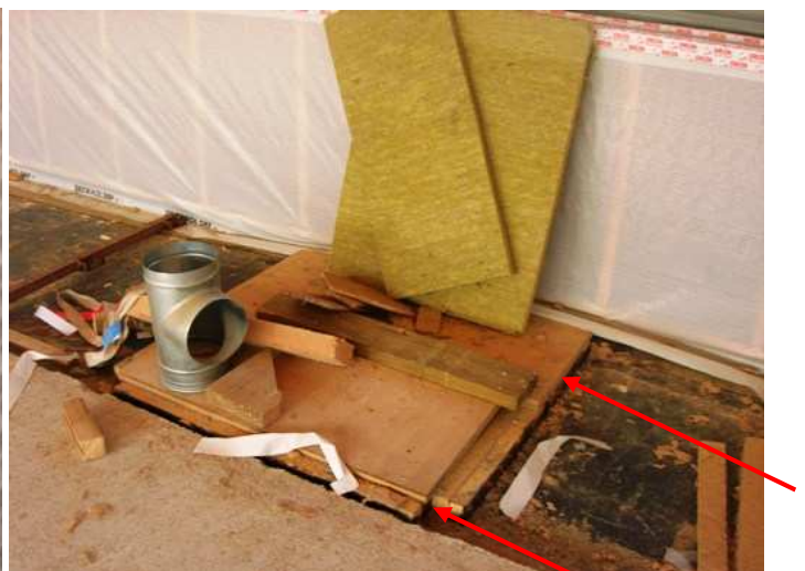
Infiltrations d'air au niveau de la descente EP et au niveau de la trappe d'occultation provisoire du skydome.
