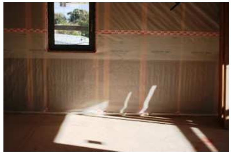
Vue générale de l'absence de contre lattage du freine vapeur collé et agrafé sur l'ossature structurelle.
