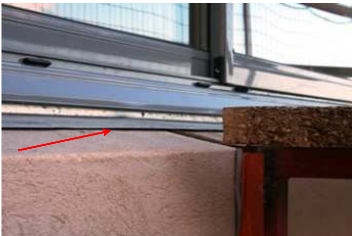
Infiltrations d'air en dessous de la couverture posée sur l'acrotère existant créant infiltrations derrière l'isolant.
