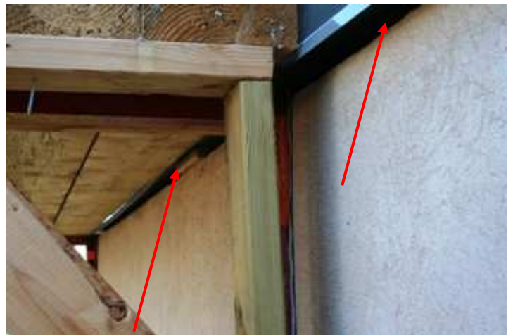
Infiltrations d'air en dessous de la couverture posée sur l'acrotère existant créant infiltrations derrière l'isolant.
