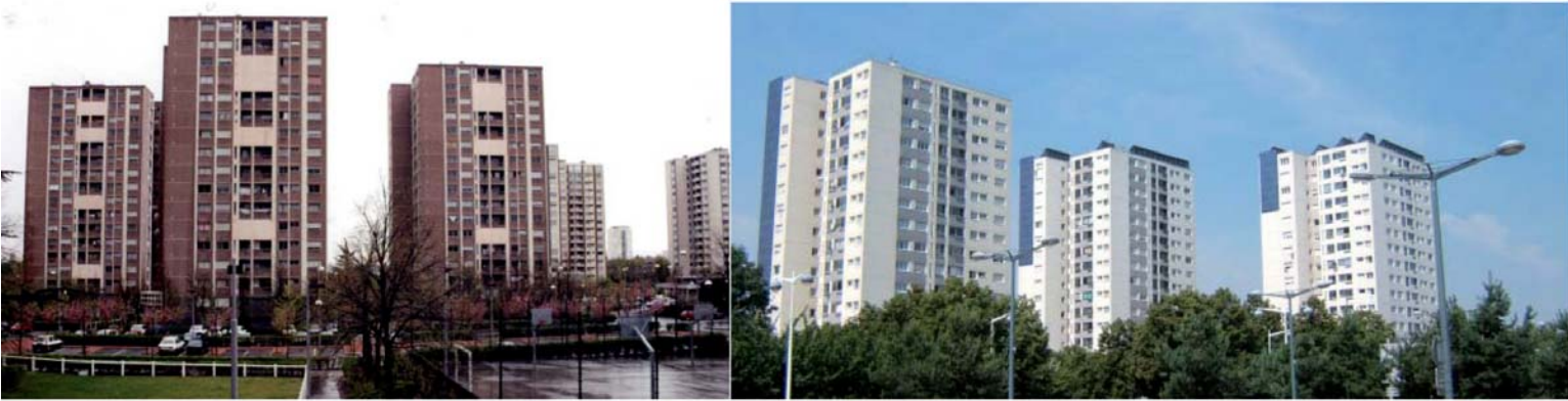
LA DARNAISE, avant et après réhabilitation Photos : Atelier d'architecture Bernard PARIS
