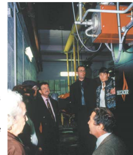
La pompe à vapeur de la Résidence Maryse Bastié ( Lyon 8 e )
